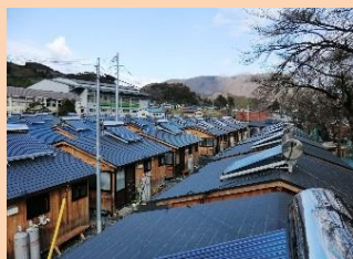
岩手県住田町 木造仮設住宅110戸
