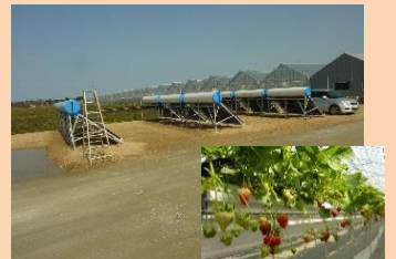
山元町イチゴハウスに9基
